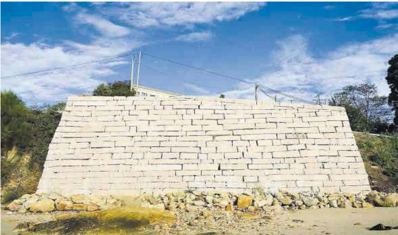
El gran muro de piedra de contención del talud de O Cocho que ha construido el Puerto. | G.N.
