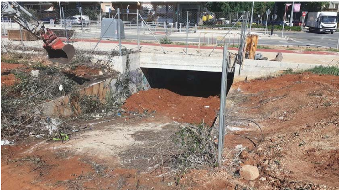
Las obras en Joan Fuster.
