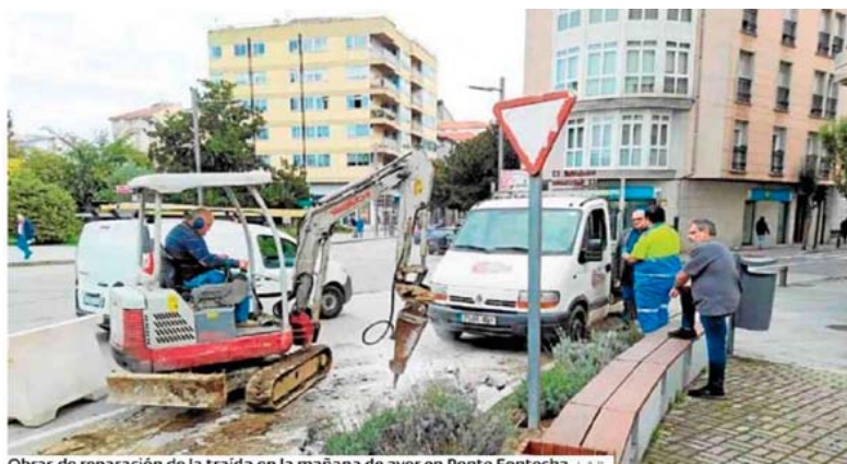
Obras de reparación de la traída en la mañana de ayer en Ponte Fontecha. L.A.R.
